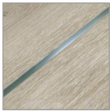
8 mm szélességű alumínium profil az ajtólapba süllyesztve
